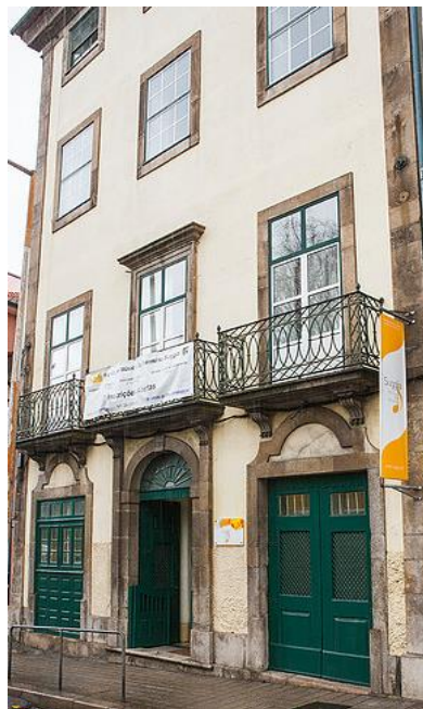
Fig.1: Fachada do Edifício
